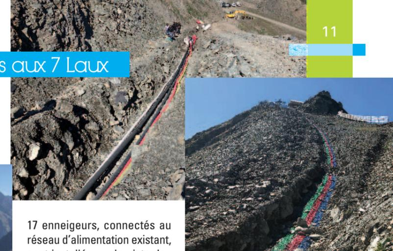
17 enneigeurs, connectés au réseau d'alimentation existant, sont installés sur la piste des Cabris, entre 1580 et 1900 m d'altitude pour couvrir 3,8 hectares de descente. Pour la piste de Coulemelle, sur les pentes Est de Roche Noire desservies par l'Oursière, 19 enneigeurs couvrent eux une surface de 3,6 hectares sur un linéaire de 1940m. La salle des machines du dôme a été renforcée à cet effet avec 1 pompe supplémentaire.
