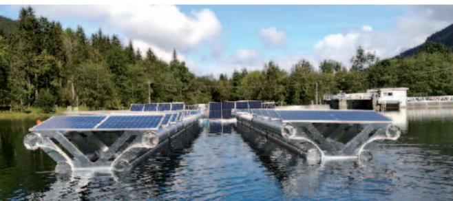
> Le système était implanté en milieu de lac pour ne pas gêner les pêcheurs, avec des flotteurs émergeant au maximum à 50 cm au-dessus de l'eau, pour un impact visuel réduit. Il devait rester uniquement 1 an et être retiré à l'issue du test.
